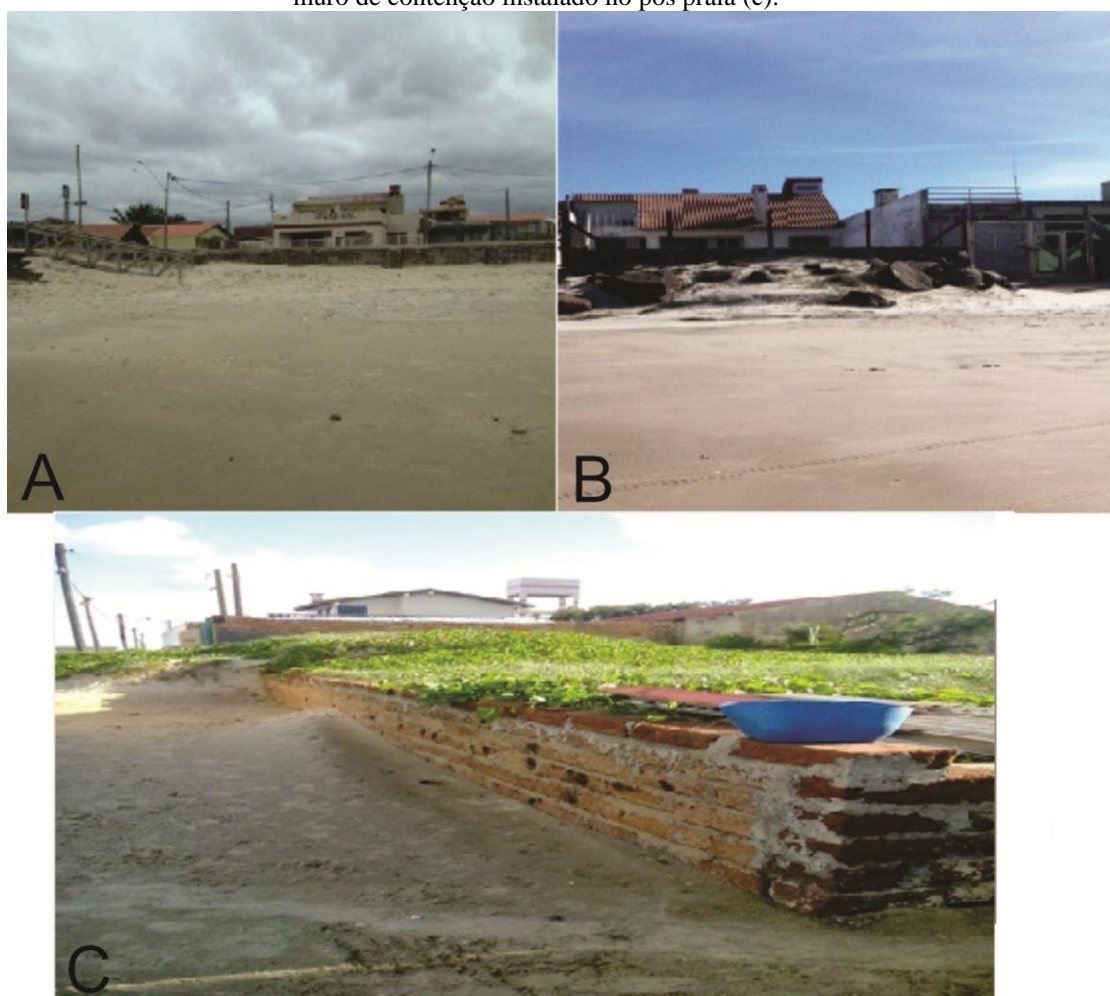
Figura 2 - Destaque para altura do pacote vertical de sedimentos acumulados junto ao calçadão (a), enrocamentos (b) e muro de contenção instalado no pós praia (c).
